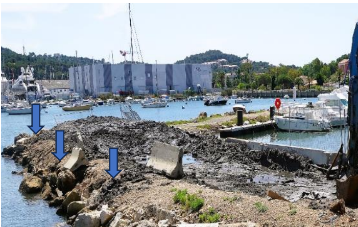
Sédiments-vases s'écoulant en dehors des limites non balisées de la zone d'entreposage directement en mer du côté de la baie du Lazaret (Photographie de gauche) et sur l'accès carrossable du côté des eaux du port du Lazaret (Photographie de droite).
