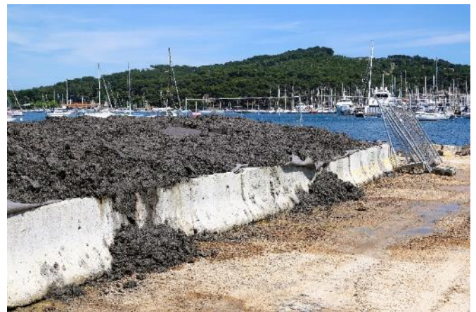
Sédiments-vases s'écoulant en dehors des limites non balisées de la zone d'entreposage directement en mer du côté de la baie du Lazaret (Photographie de gauche) et sur l'accès carrossable du côté des eaux du port du Lazaret (Photographie de droite).
