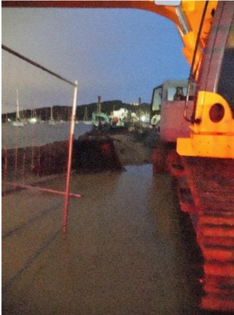
Écoulement du filtrat issu des sédiments-vases entreposés vers les eaux de mer de la baie du Lazaret (Photographie de gauche) et du port du Lazaret (Photographie de droite)
